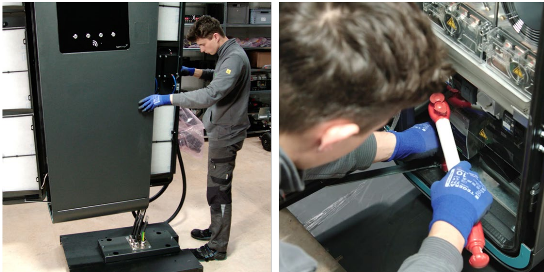
Abbildung 48: Positionierung HYC400 auf Sockel und Befestigung
